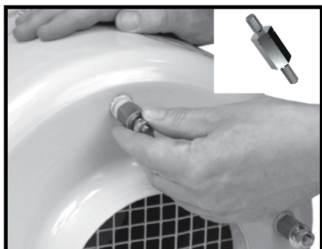
Trinn 1. Monter dekselpigger som for direkte montering.
