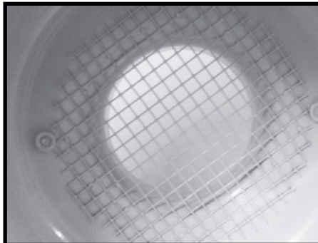
Trinn 8. Kontroller at innløpsgitteret er klart.
